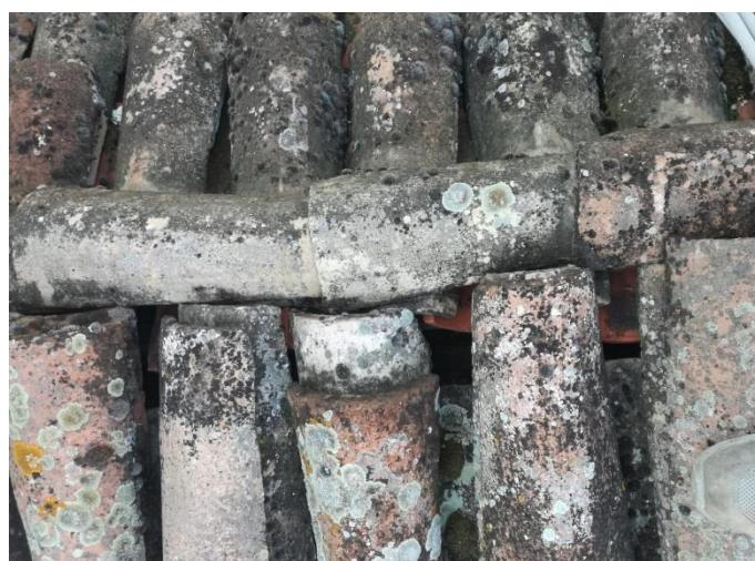
è stata condotta un’ispezione a cestello prima dei lavori, che ha evidenziato un significativo disallineamento del colmo con apertura di fessure
