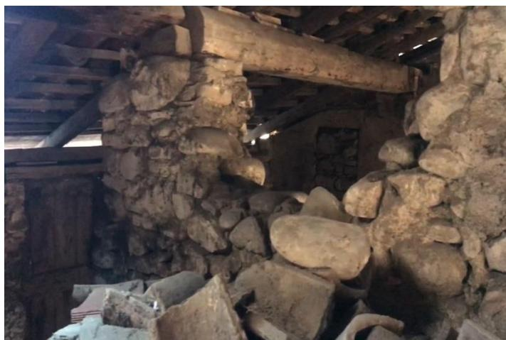
Scatti fotografici delle coperture eseguiti prima degli interventi che evidenziano l'ammaloramento dei lignei e delle murature di appoggio.
